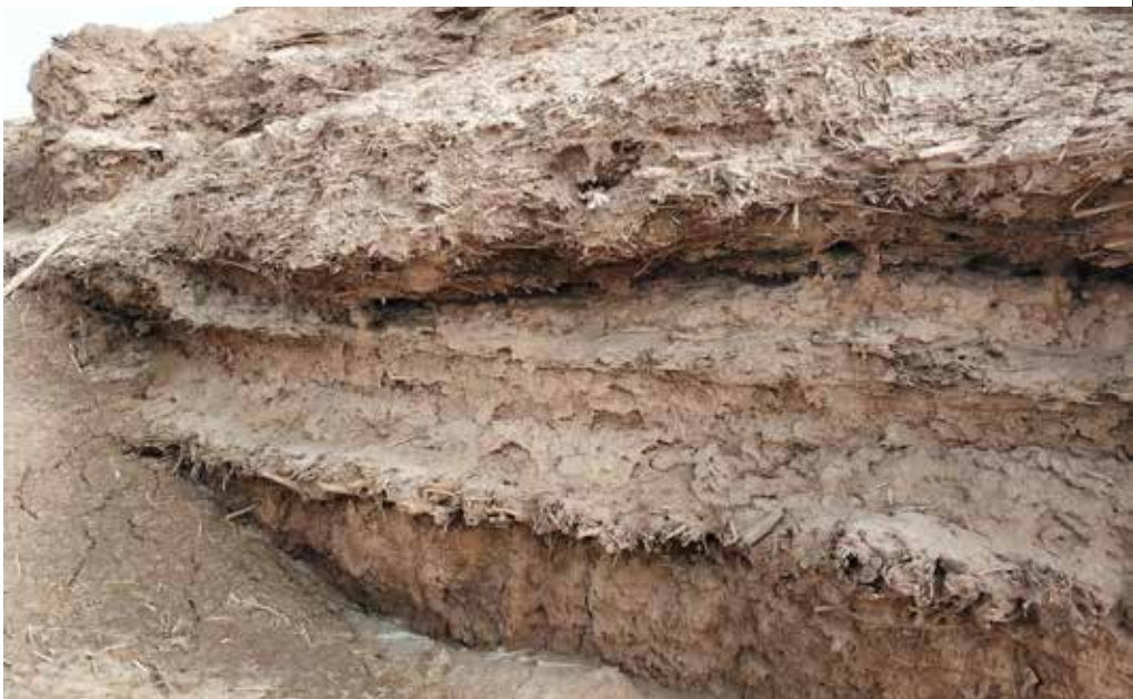
烽燧基座由黄泥与红柳枝相间的“红柳混凝土”结构。
